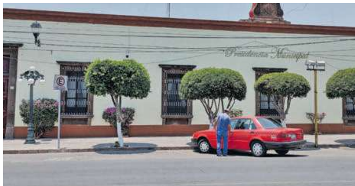
La infraestructura del edificio se encuentra en buenas condiciones. JENA GUZMÁN
