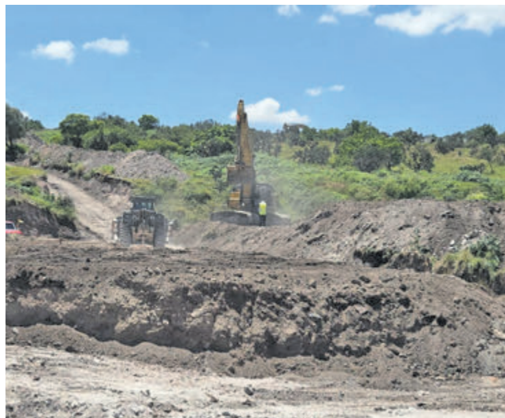
Se realizan trabajos en la zona donde pasará el tren. JENA GUZMÁN
