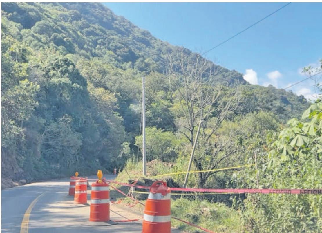
Los caminos se encuentran en obra. ESTRELLA ÁLVAREZ
