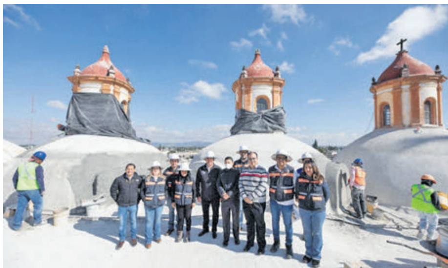
Las obras concluirán en enero. ESPECIAL
