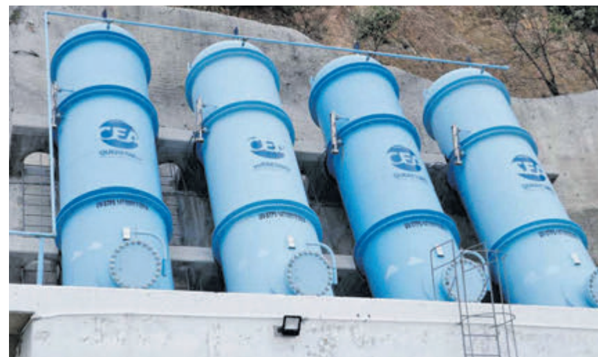
El Acueducto II fue suspendido durante el desfogue de la presa Zimapán, lo cual ocasionó una interrupción en el servicio de agua. CORTESÍA
