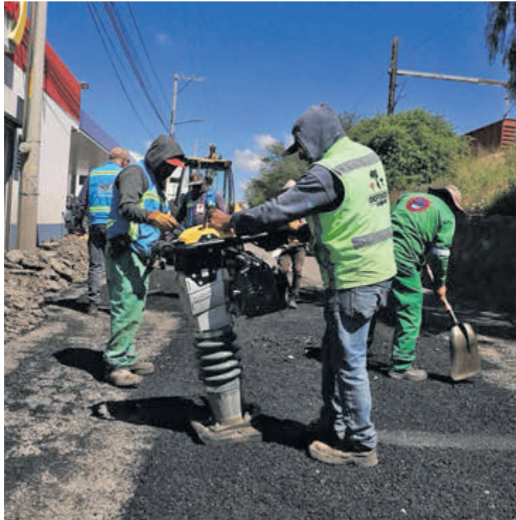
Continúan las obras de bacheo. JENA GUZMÁN
