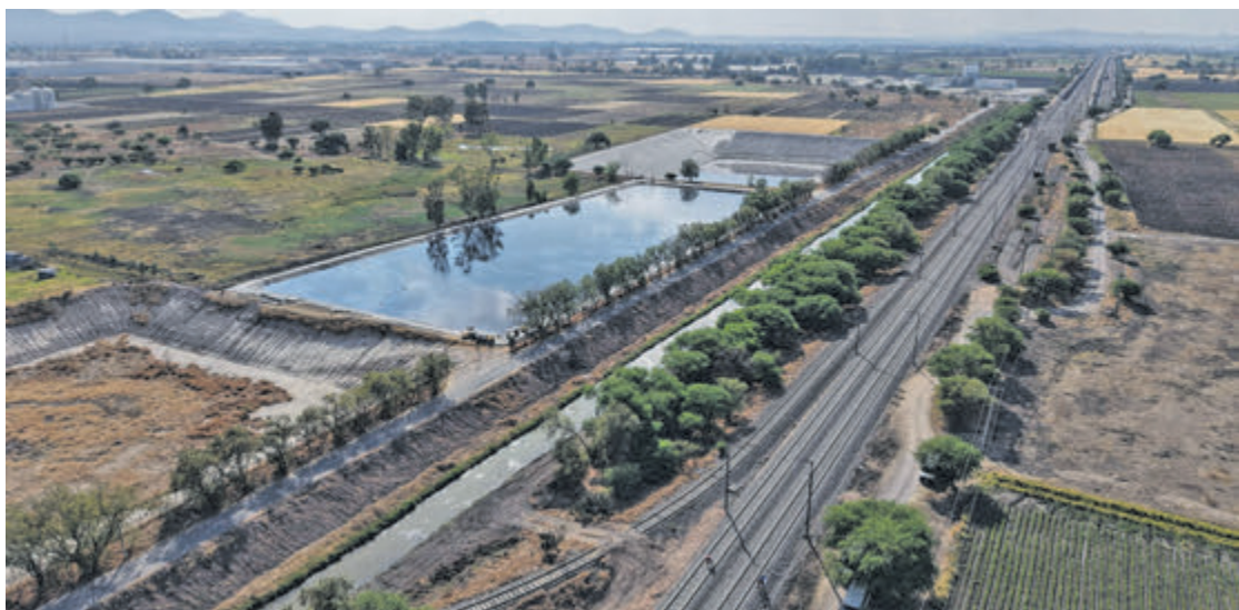
En abril, comenzaron los trabajos del tren México-Querétaro. CUARTOSCURO
