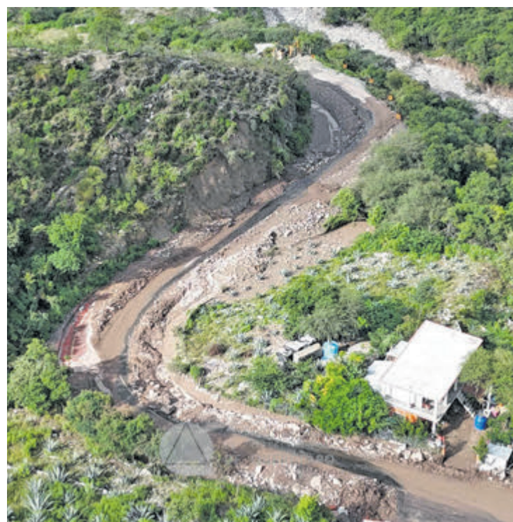
Diversos caminos fueron dañados por las lluvias. ESPECIAL
