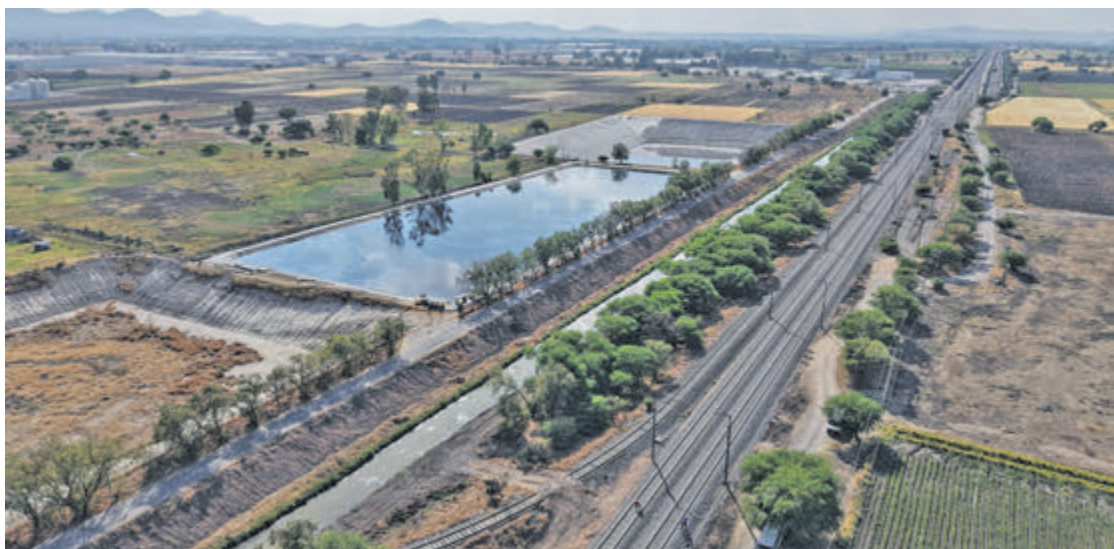
En abril de este año iniciaron las obras del tren México-Querétaro. CUARTOSCURIO
