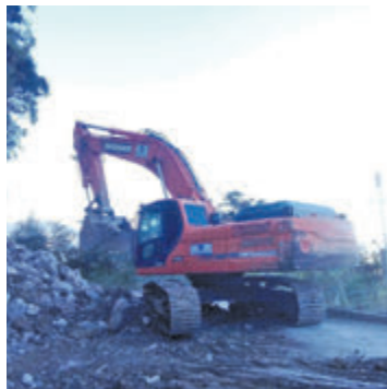
La CEI repara caminos dañados en la sierra. ESPECIAL
