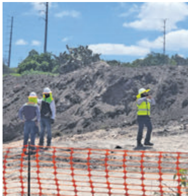
Continúan los trabajos por tren México-Querétaro. JENA GUZMÁN
