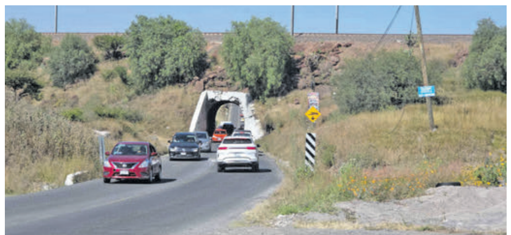
El puente a la carretera 300 es una de las obras más requeridas. JENA GUZMÁN
