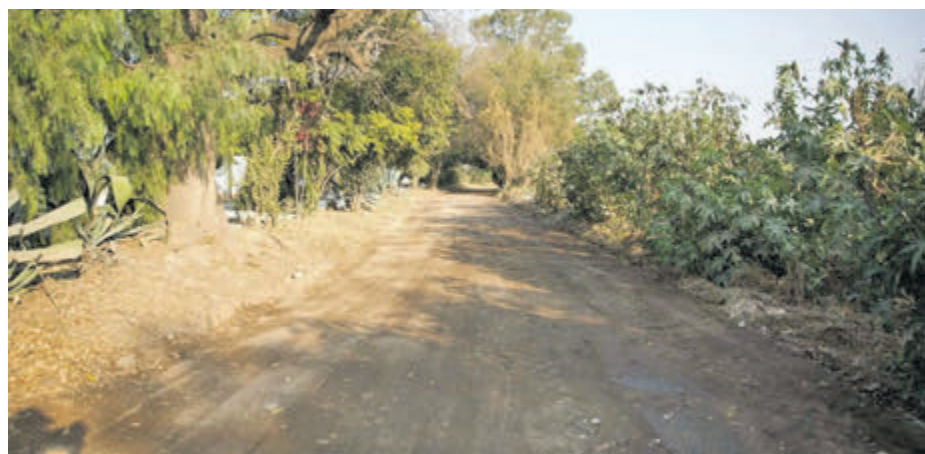
Se realizaron labores de desmonte y retiro de vegetación. JENA GUZMÁN
