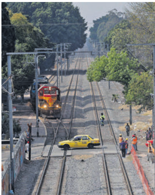
La próxima semana inician obras. CUARTOSCURO
