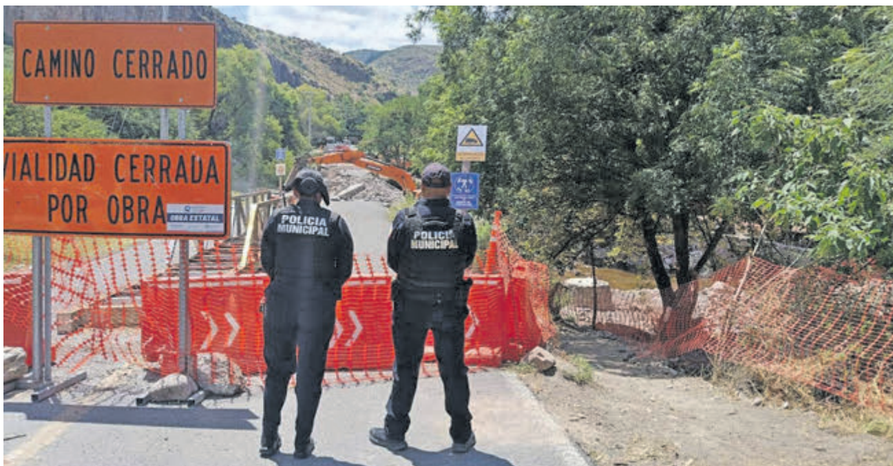
El puente tuvo afectaciones graves en su estructura debido a las lluvias. ESPECIAL
