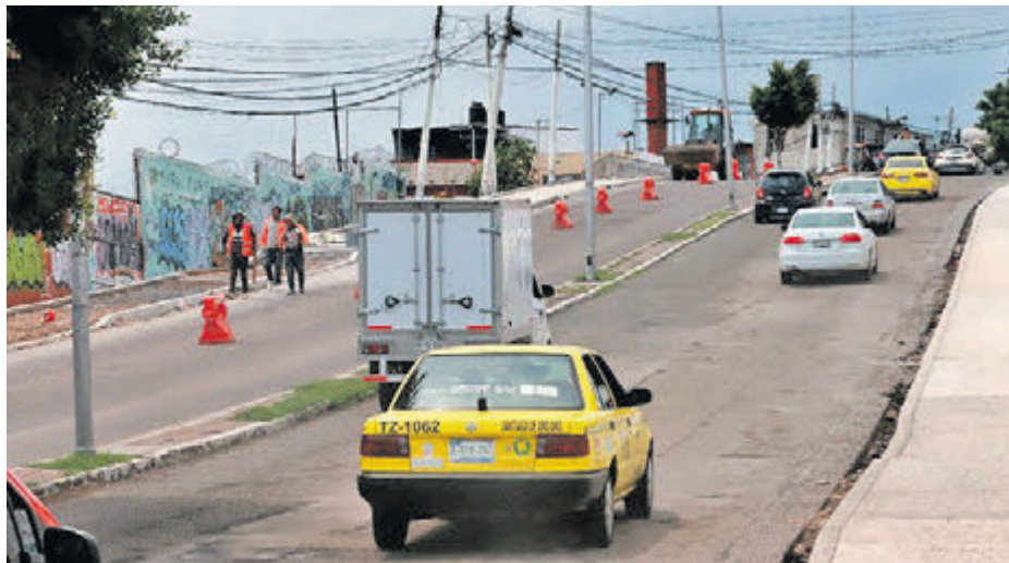
El cierre de este tramo podría generar afectaciones graves. CORTESÍA
