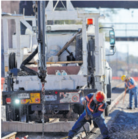
Algunas obras del tren ya comenzaron en la zona de El Cerrito. CUARTOSCURO
