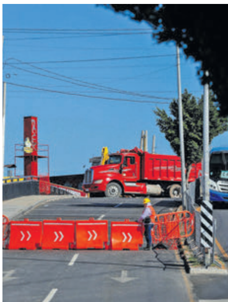
En la capital ya hay trabajos por el proyecto ferroviario. CUARTOSCURO
