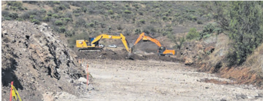
Continúan las obras de movilidad. ESPECIAL
