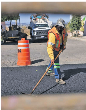
La CEI participó en la rehabilitación. JENA GUZMÁN
