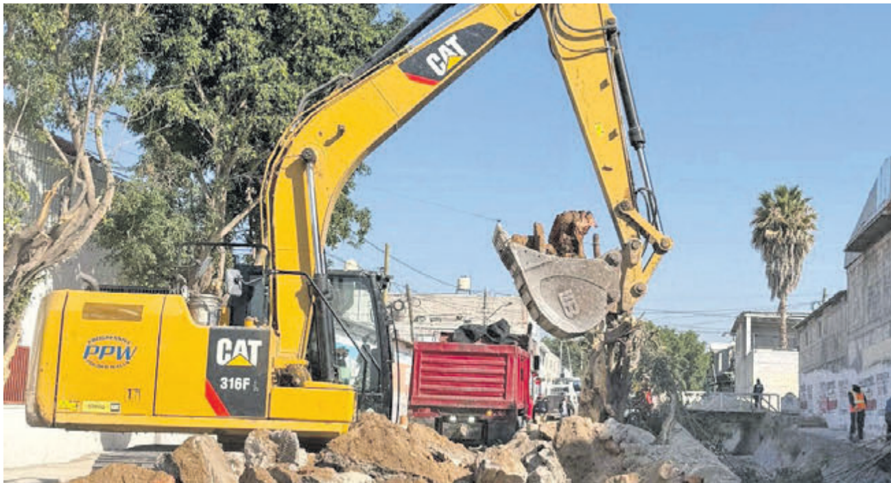
Se realizan obras en el dren de Peñuelas. ESTRELLA ÁLVAREZ
