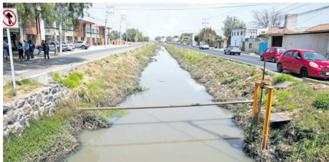
Autoridades buscan eliminar el lirio y evitar pérdidas del líquido vital. ESPECIAL
