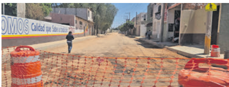
La obra beneficiará a la cabecera municipal. JENA GUZMÁN
