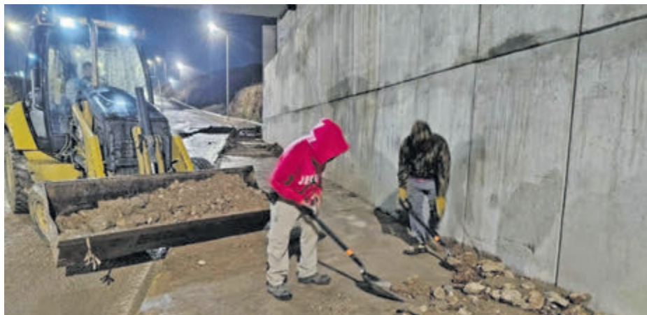
Se realizan labores de limpieza para evitar taponamientos. ESPECIAL
