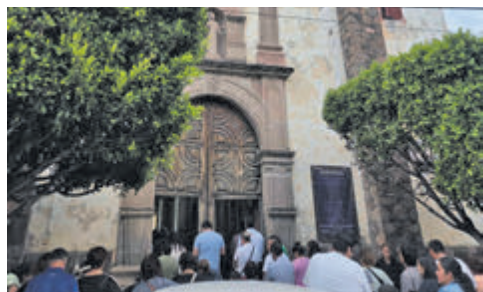
Nuevos templos se suman a la rehabilitación. JENA GUZMÁN
