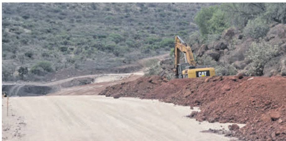
La obra registra avances continuos. JENA GUZMÁN
