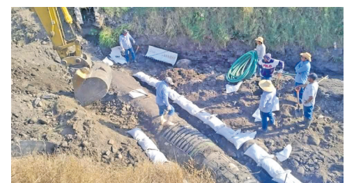
Personal de la JAPAM trabaja para arreglar las fallas. JENA GUZMÁN
