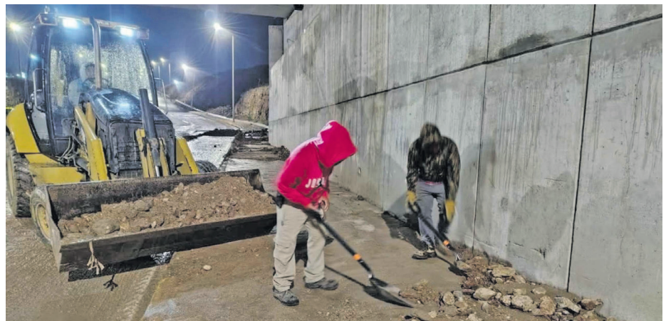
Se realizan labores de limpieza para evitar taponamientos. ESPECIAL
