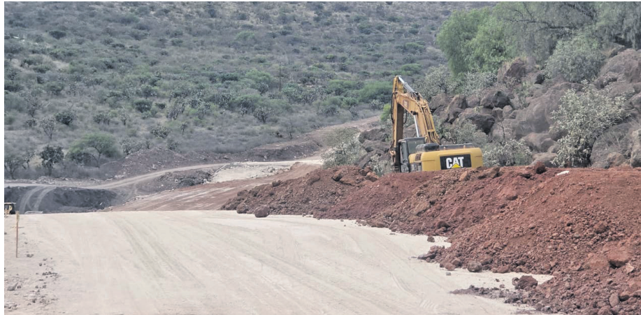
La obra registra avances continuos. JENA GUZMÁN
