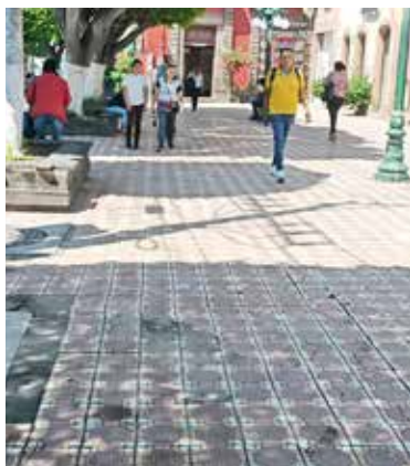
Las acciones forman parte de un programa de obra pública.
