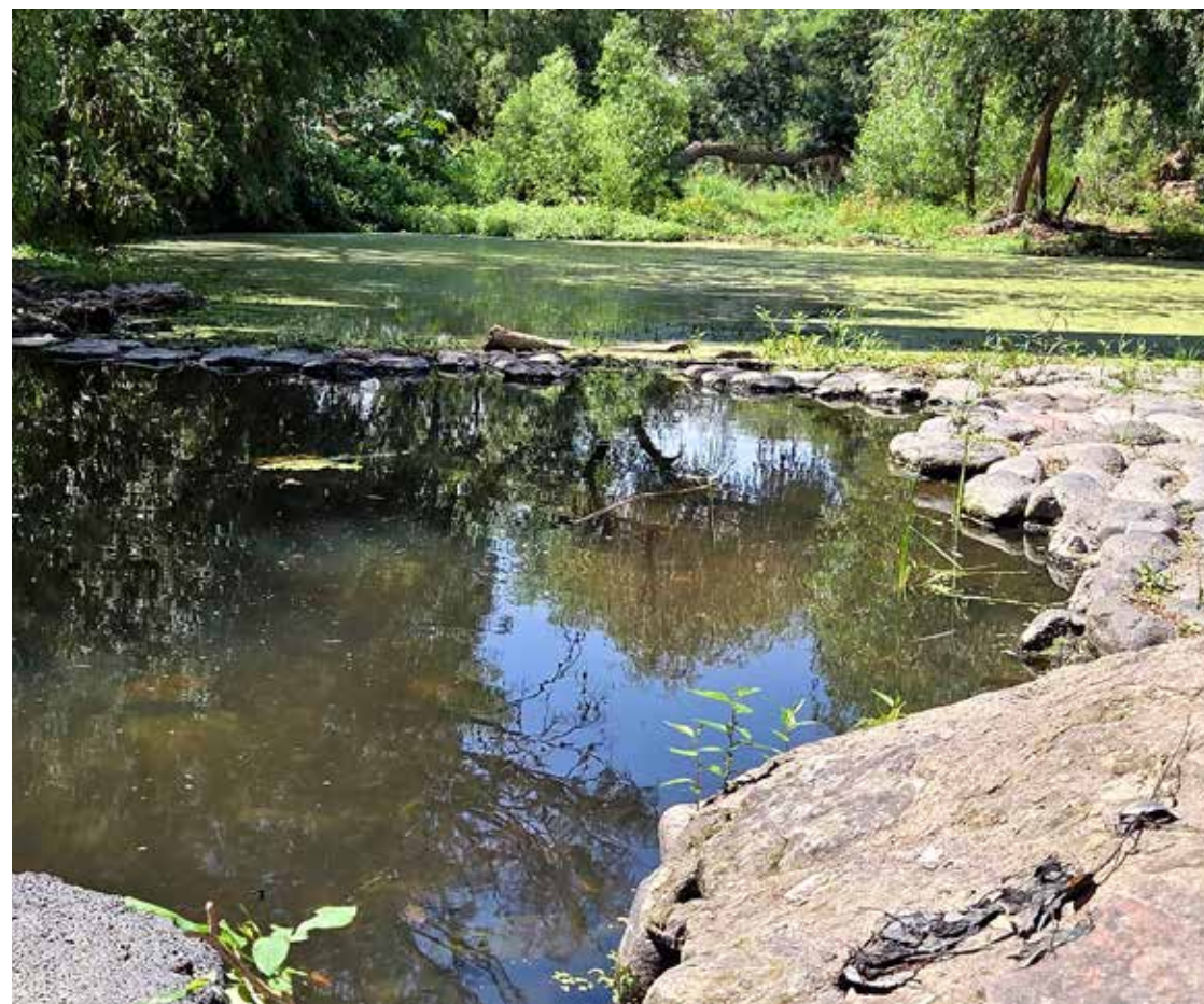
Se realizan trabajos de desazolve y saneamiento del río.
