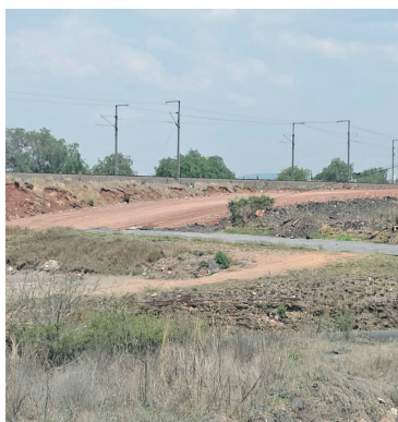
Las obras del tren arrancaron a fines de 2024. ESPECIAL
