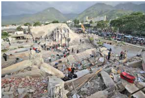
Equipos de rescate buscan sobrevivientes entre los escombros. ESPECIAL
