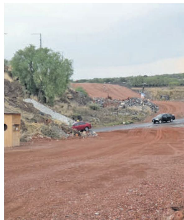
La Sedena realiza trabajos en el frente correspondiente a San Juan del Río. JENA GUZMÁN
