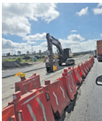
Trabajan para que las obras avancen conforme a los plazos establecidos.
