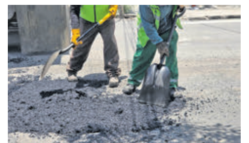
No se han reportado daños de consideración. JENA GUZMÁN
