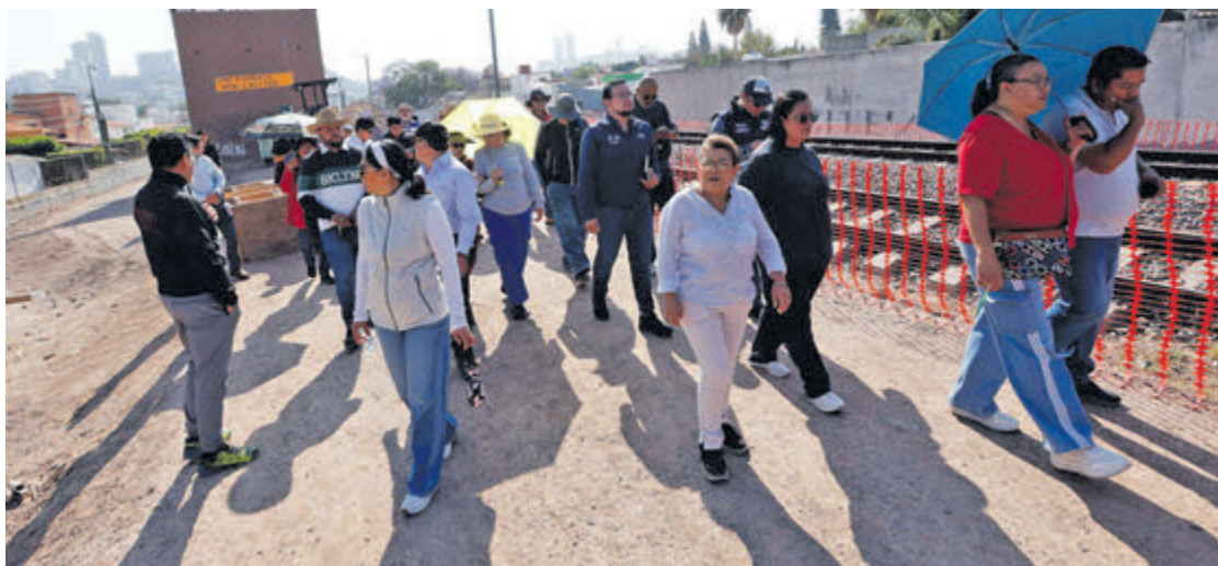
En abril hubo obras alrededor del barrio de El Tepe, por el tren. CUARTOSCURO
