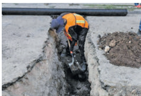
La JAPAM realiza la obra hídrica. ESPECIAL
