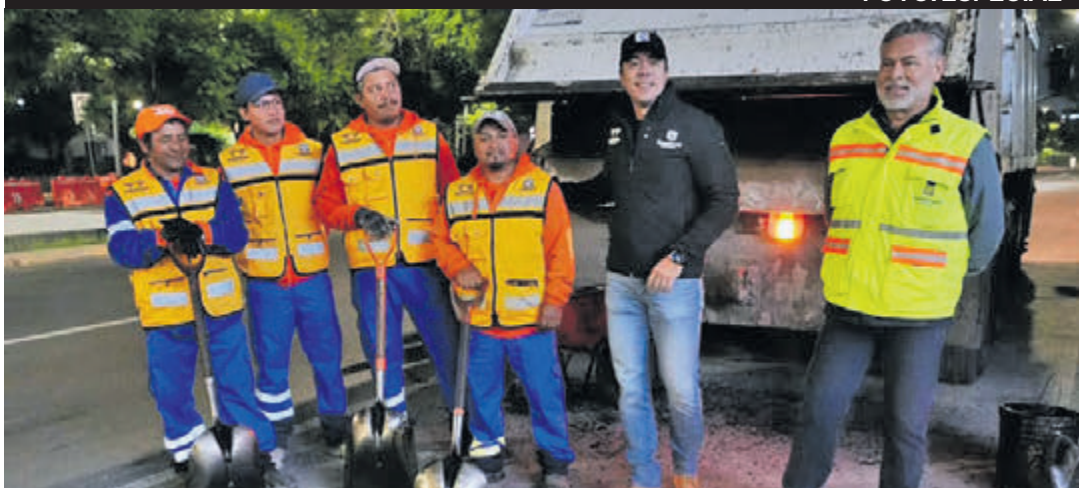
Supervisa 'Felifer' Macías trabajos de mantenimiento vial en Querétaro. PÁG. 02
