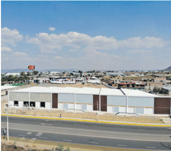
Algunos de estos proyectos ya pasaron a la etapa de construcción. ESPECIAL
